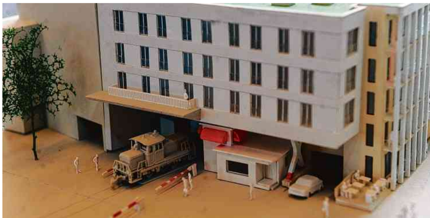
Eine Lok kommt aus dem neuen Tunnel. Auch ein denkmalgeschütztes Stellwerkhäuschen daneben wird überbaut.
