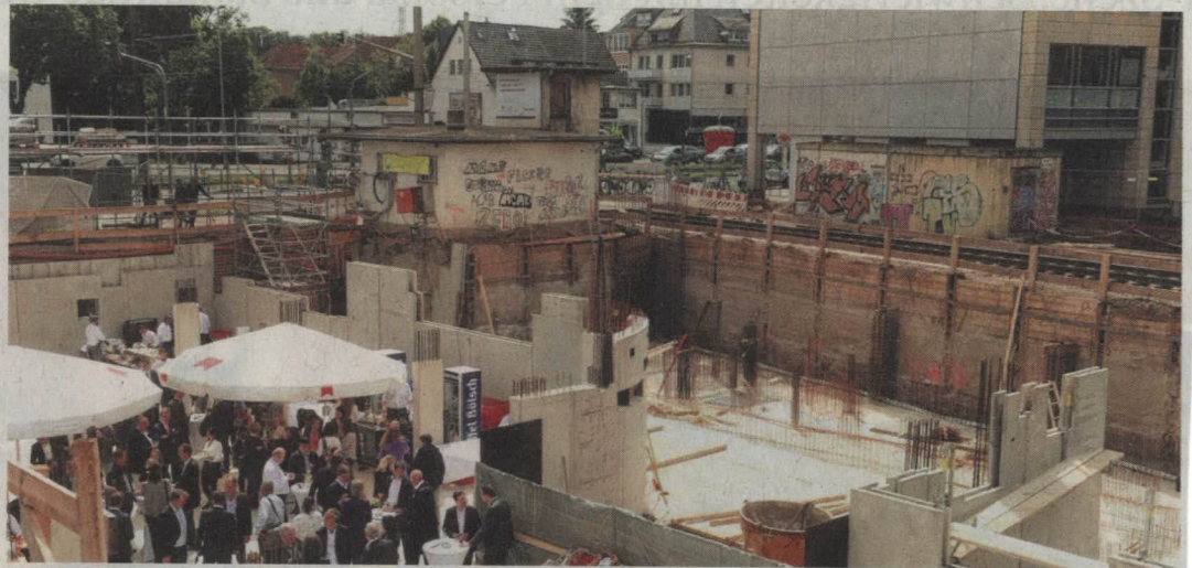
Grundsteinlegung in der Baugrube: Rechts hinten sieht man die Schienen, die überbaut werden. Das Eisenbahnerhäuschen mit Turm soll in den Gebäudekomplex integriert werden. Foto: Rakoczy
